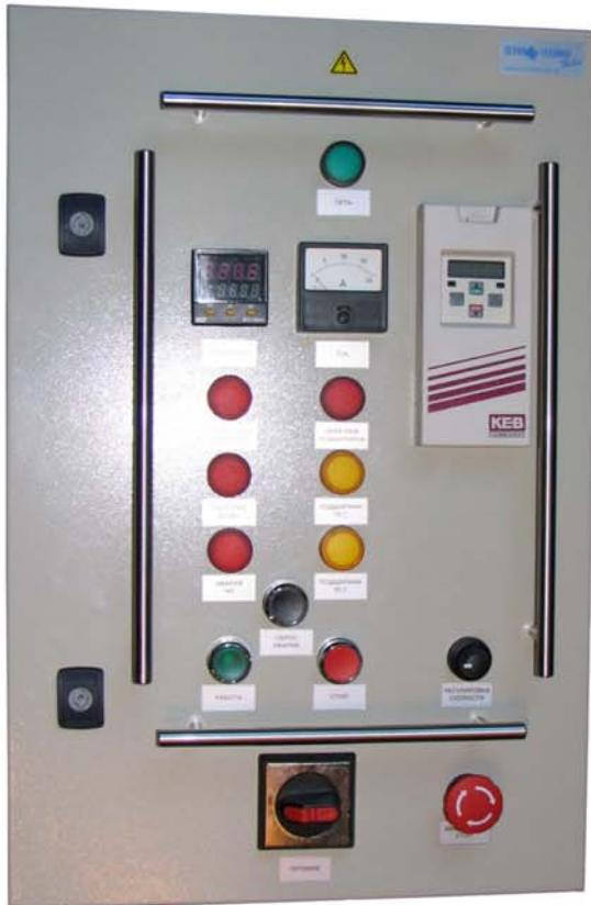
В качестве двигателя привода мельницы используется высокоскоростной шпиндель итальянской фирмы Elte с частотой вращения 18000 оборотов в минуту. Питание шпинделя осуществляется от преобразователя частоты фирмы KEB типа F5 BASIC. Шкаф управления приводом обеспечивает также контроль температуры подшипников и уровня вибрации.
