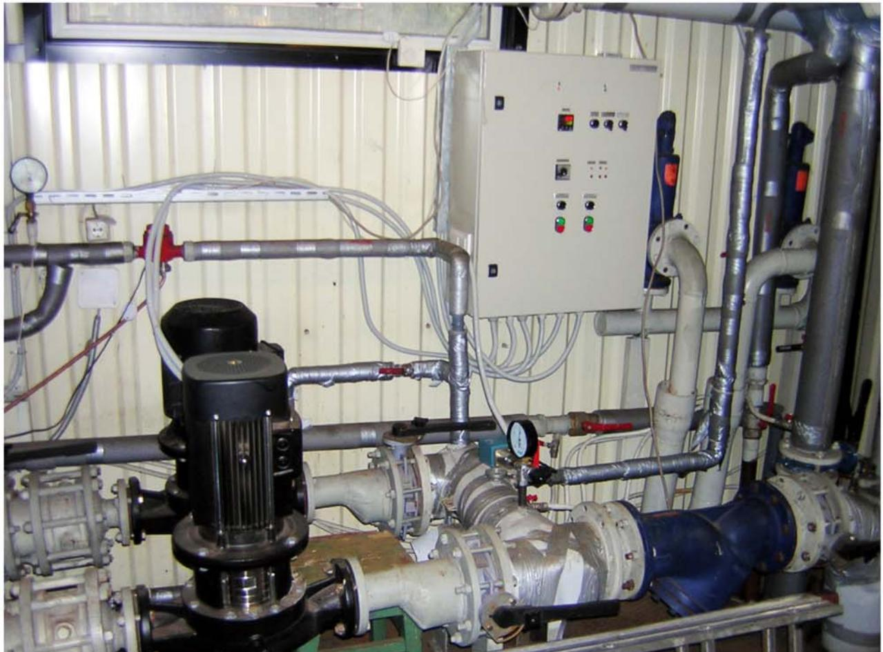
Станция обеспечивает поддержание заданного давления в магистрали и периодическое переключение насосов для обеспечения равномерного износа оборудования. Так же обеспечивается возможность ручного управления насосами и аварийное включение резервного насоса при отказе рабочего, выдача сигналов аварийной сигнализации.
